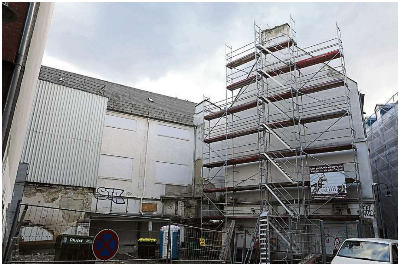
Die Brandwand in der Walhalla-Baulücke an der Hochstättenstraße ist für die Sicherungsmaßnahmen eingerüstet.
